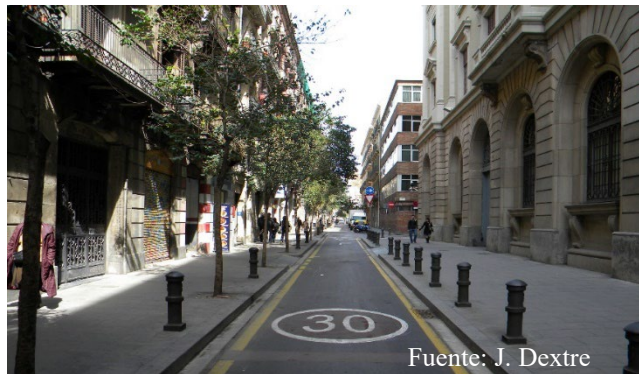
Figura 2. Carriles de 2.80 m. para velocidades de 30 km/h
