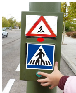
Figura 6. Se muestra la imagen de la situación se tendrá que dar difusión al uso de esta señal para que no se haga mal uso de ella.
